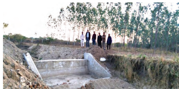
जल संचयन संरचना में जल के प्रवेश एवं निकासी स्थलों की मरम्मत
